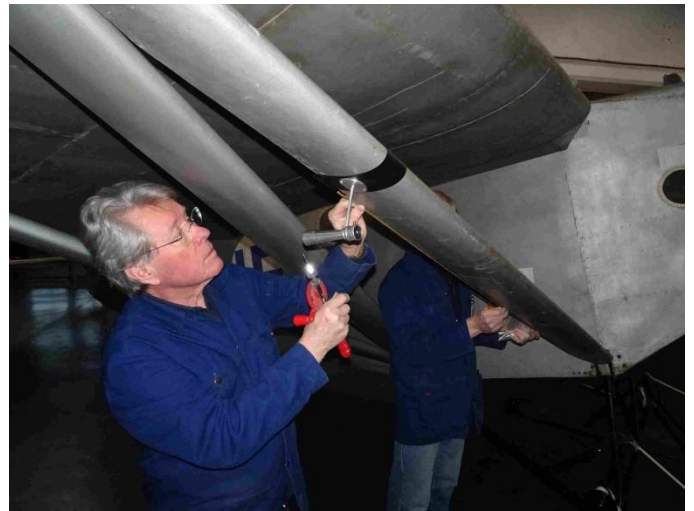
Venturiputkea asennetaan Kurjen siipitukeen.
