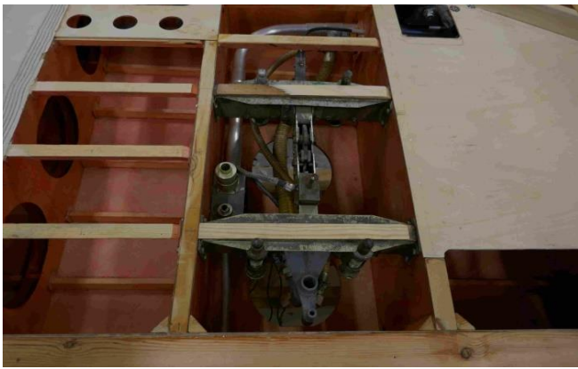
Siiven sisään asennettu lisäpolttoainetankin ja pommin ripustin
